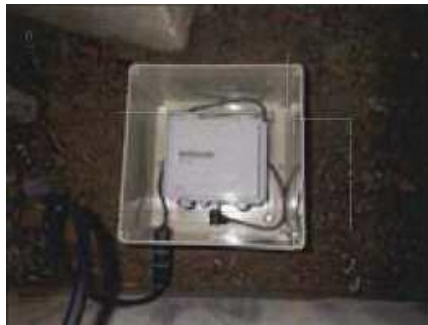
① 1階レベル (北西側構台下)
