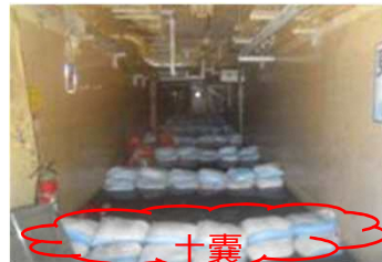
PMBの土嚢状態（設置時）
