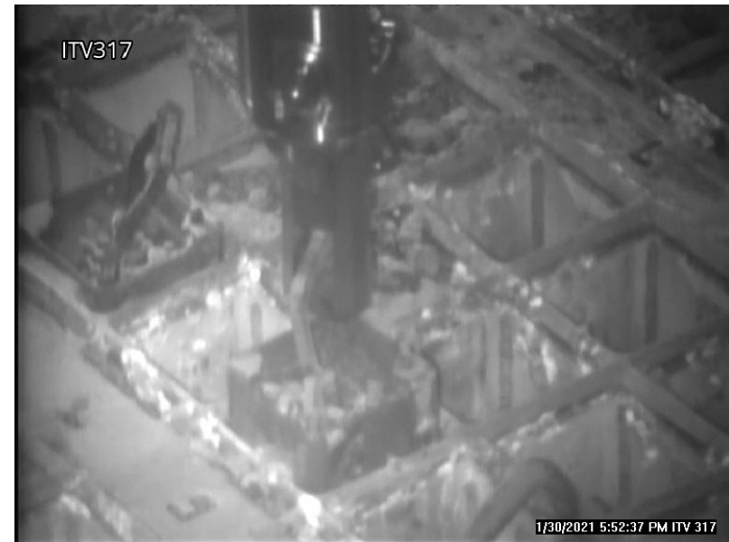
吊り上げ状況例 (⑩)
