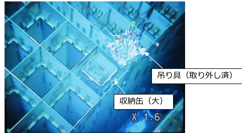
共用プールでの燃料ラックへの収納
