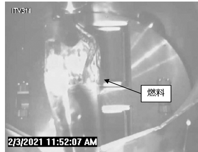
3号機での輸送容器への装填
