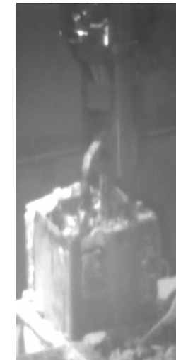
吊り上げ状況
