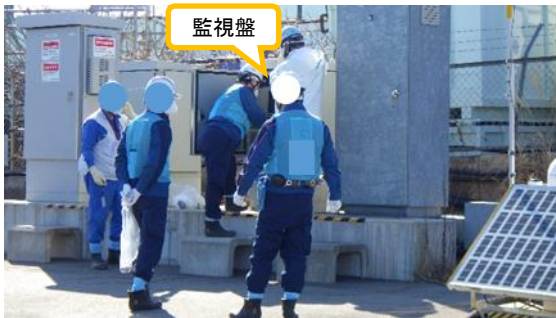
(写真3) 監視盤点検作業の状況
