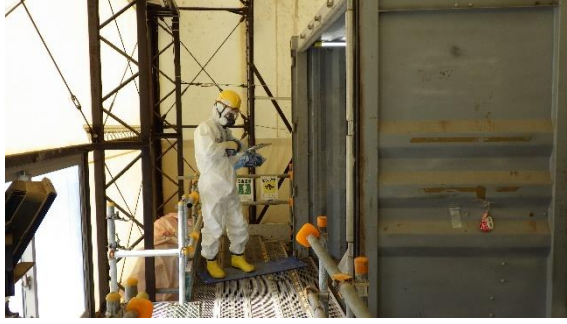
(写真6) 淡水化装置（RO2）建屋内の空間 放射線量率測定の様況
