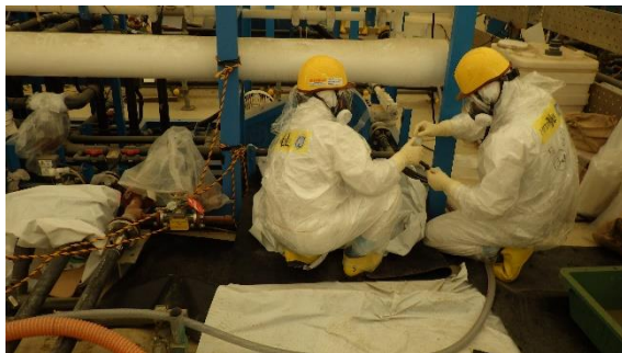
(写真 4) 残水の抜取り作業の状況
