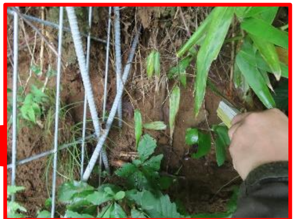
図10-4 ワイヤーメッシュを地面に合わせて隙間なく設置
