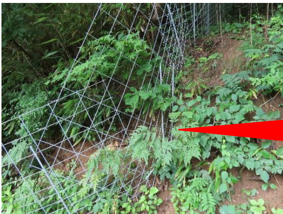
図10-4 ワイヤーメッシュを地面に合わせて隙間なく設置
