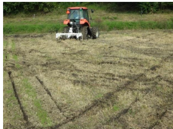
図 4-2 サブソイラーによる補助暗渠施工
