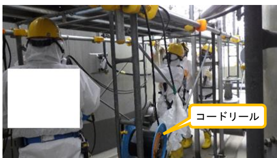
(写真2) 電源ケーブル敷設作業の状況
