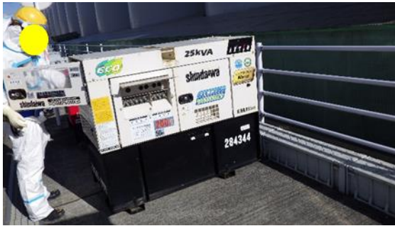
(写真3-2) 発電機点検作業の状況
