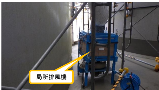
(写真1-3) 局所排風機設置状況
