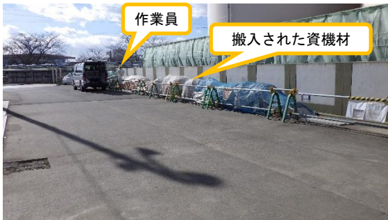
(写真4) K1南タンクエリア堰外(東側)の状況
