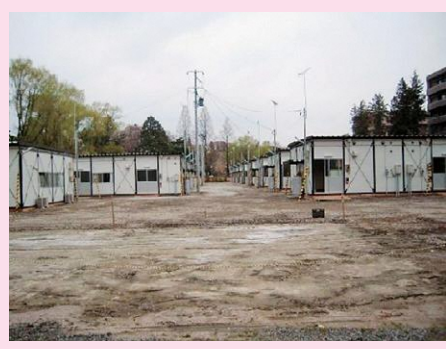
当初建設時(北側より撮影)
