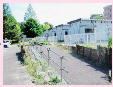
嵩上げ後(北側より撮影)
