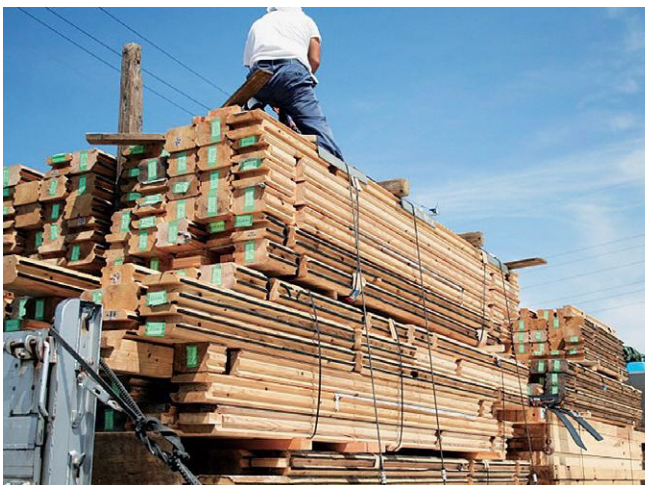
移設にあたっての運搬積み込み(部材の番付)
