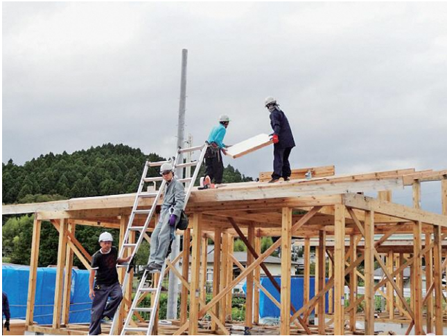
移設後の組立状況
