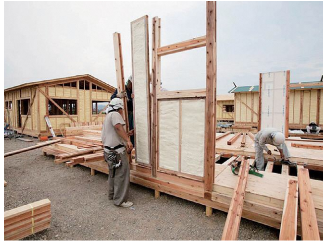
移設後の組立状況
