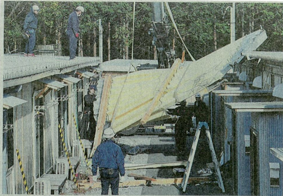
強風で吹き飛ばされた屋根の撤去作業に追われる作業員 ＝9日午後3時20分ごろ、新地町・がんど屋仮設住宅
