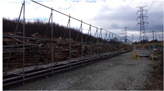
(写真1-4) エリア北西側の状況 (北西側から撮影) (令和3年1月22日)
