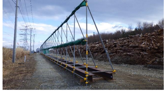
(写真1-2) エリア南西側の状況 (南西側から撮影) (令和3年1月22日)
