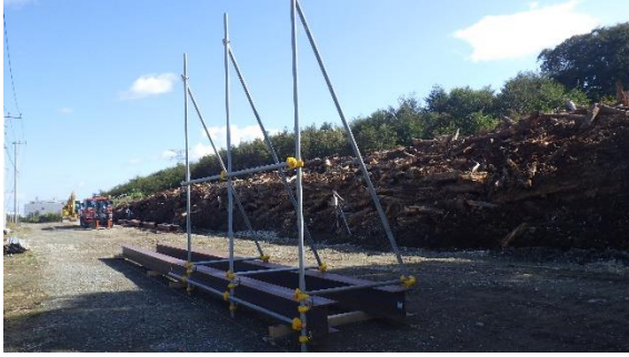
(写真1-1) エリア南西側の状況 (南西側から撮影) (令和2年11月4日)
