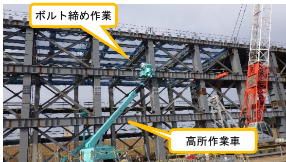
(写真2) 高所作業車を使用したボルト締め作業の状況
