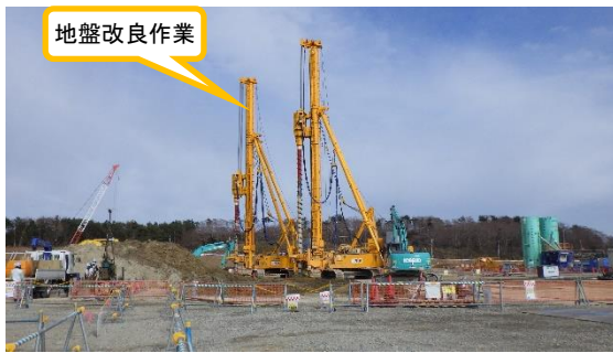
(写真3) 地盤改良箇所の状況
