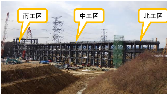
(写真1-1) 大型廃棄物保管庫建設現場 (北東側から撮影)
