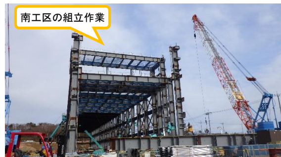
(写真1-3) 今回の状況 (南工区) (令和3年1月18日撮影)
