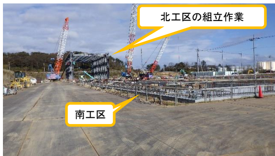
(写真1-2) 前回の状況 (南西側から撮影) (令和2年11月30日撮影)
