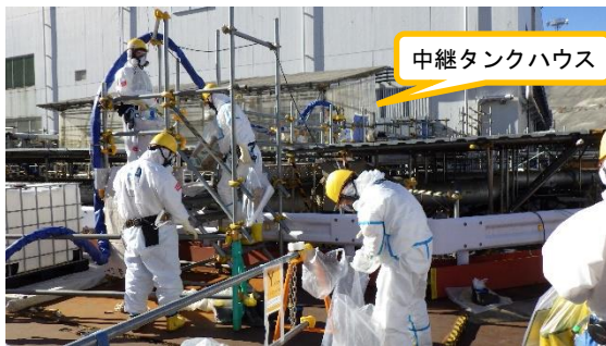
(写真1-1) 中継タンクハウス外観
