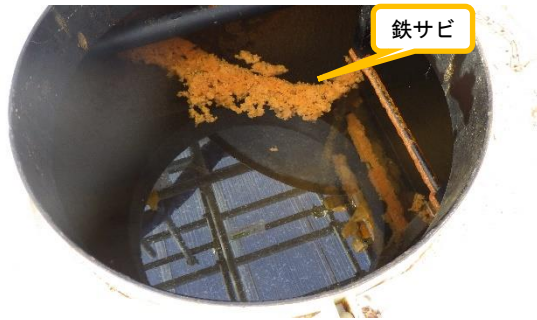
(写真2) 中継タンク内の状況 水面に若干の細かい油膜あり。また、鉄サビも浮遊していた。
