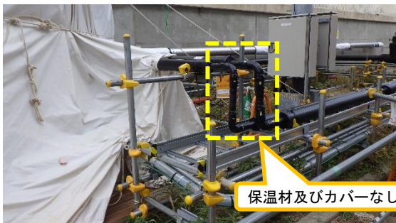
(写真5-1) サブドレン所鉄装置南東側の配管敷 設状況(南西側から撮影) 前回(11月12日)撮影
