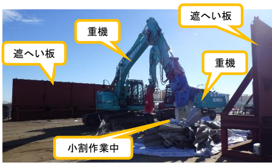
(写真6) 小割作業の状況
