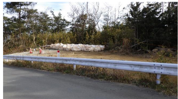
(写真3-2) 今回の状況 (令和2年12月24日撮影)
