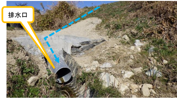
(写真3) 南側法面の排水箇所状況
