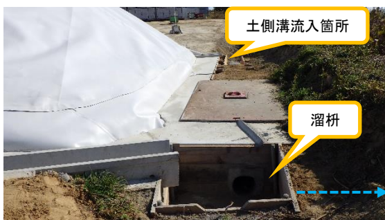
(写真2-3) 第1槽からの溜柵及び土側溝流入箇所
