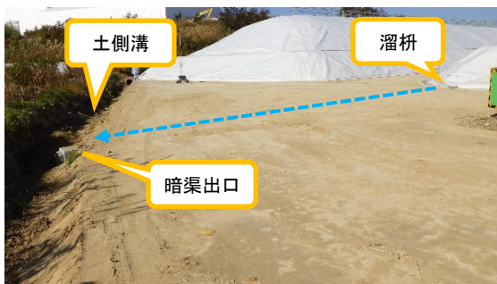
(写真2-2) 第3槽からの土側溝流入箇所
