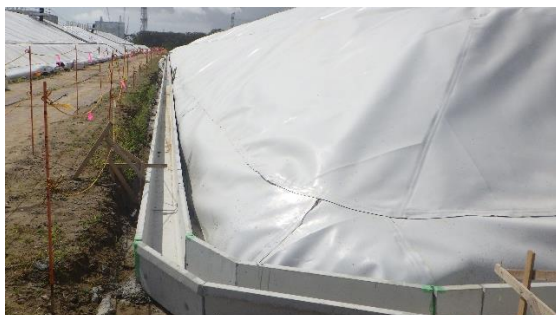
(写真1-2) 前回（令和2年9月15日）撮影 第2槽の側溝の状況
