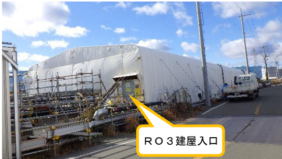
(写真1) RO3 建屋の外観 (北東側から撮影)
