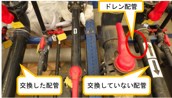
(写真 2 - 2) UF 出口処理水配管の交換状況② (交換した配管にはドレン配管が接続 されていない)
