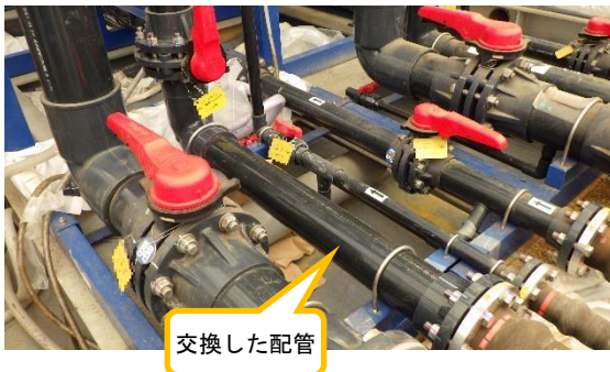
(写真2-1) UF 出口処理水配管の交換状況①
