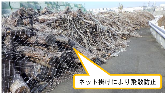
(写真 2) 飛散防止対策の状況
