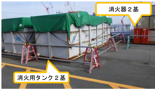
(写真 4) 保管物の近傍に消火器等が設置
