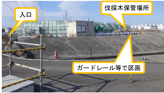
(写真 1 - 1) 伐採木一時保管エリアVの外観
