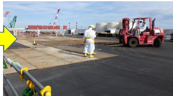
(写真2-2) 2号機タービン建屋東側ヤードの状況 （今回(12月2日)南西側から撮影）
