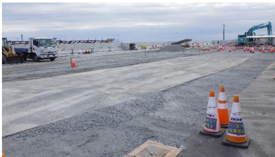
(写真3) 4号機タービン建屋東側ヤードの状況 （北西側から撮影）
