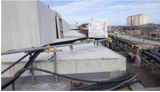
(写真1-2) 千島海溝津波防潮堤海側（4号機タービン建屋側）の状況（南側から撮影）
