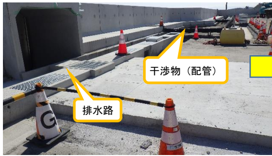
(写真4-1) 3～4号機タービン建屋東側の排水路 整備等の状況 (前回(10月27日)北側から撮影)
