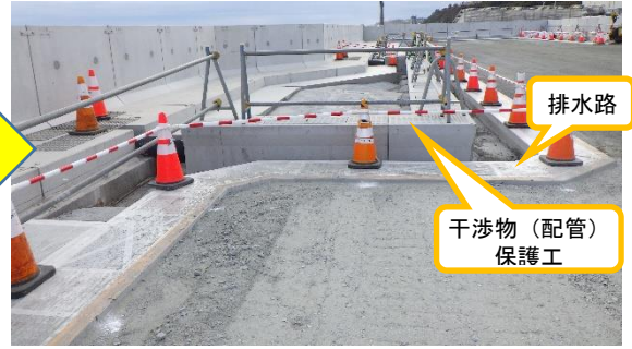
(写真4-2) 3～4号機タービン建屋東側の排水路 整備等の状況 (今回(12月2日)北側から撮影)
