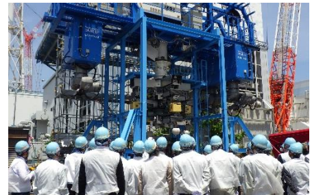
〈廃炉安全監視協議会立入調査〉 (1/2号機排気筒切断装置)
