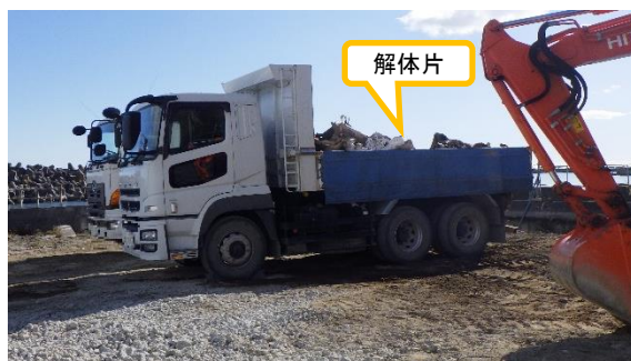
(写真2) 運搬用トラックに積載されたタンク 解体片の状況
