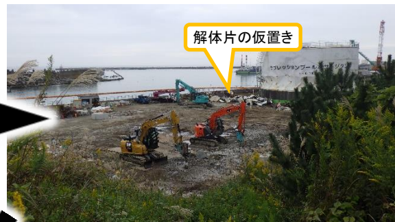
(写真1-2) 重油タンク解体後の状況 (令和2年10月22日撮影)
