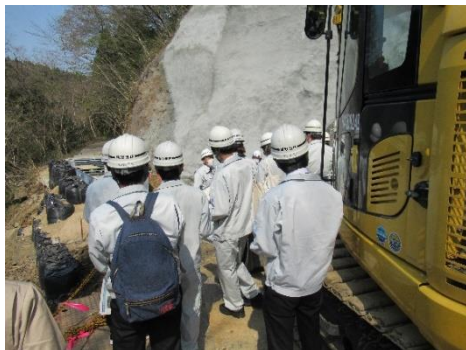
右岸幹線用水路復旧工事視察 (相馬市山上地区)
