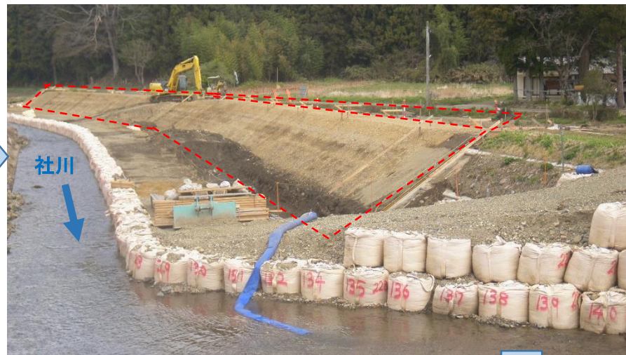
【施工状況（令和2年5月14日撮影）】
