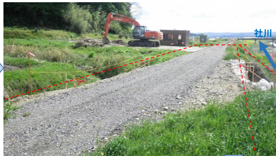
【施工状況（令和2年5月14日撮影）】
