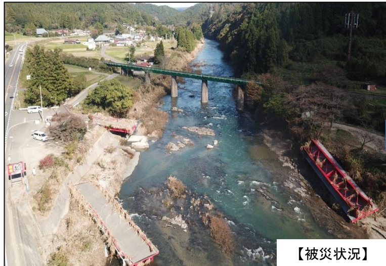
矢祭町 高地原橋
