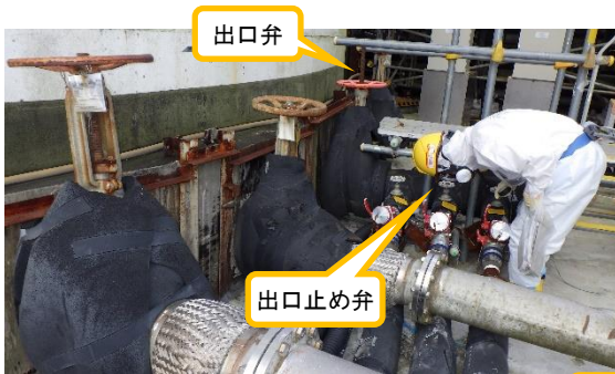
(写真3-2) No.1 純水タンクの出口弁等の状況
