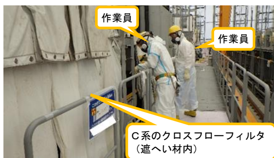
(写真1) パトロールの状況 懐中電灯で照らし、遮へい材内の状況を確認している
