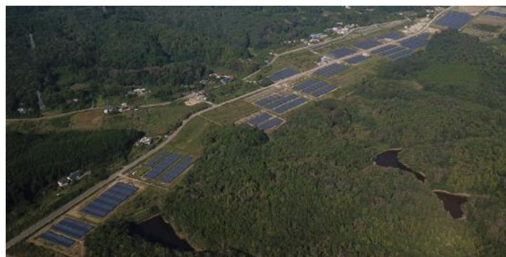
双葉渋川太陽光発電所全景
