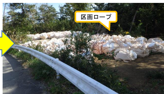
(写真4-2) ガレキ類一時保管エリアP1南側の仮置き状況
