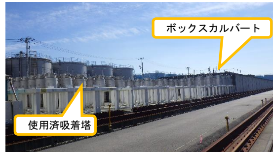
(写真 2 - 2) 同左 (手前側が使用済吸着塔、奥側がボックスカルバート)
