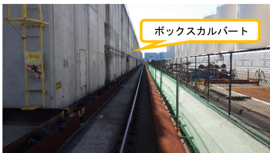
(写真1-2) 保管物はボックスカルバートの中に 収納
