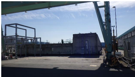
(写真 3 - 1) 第二施設北側の状況
