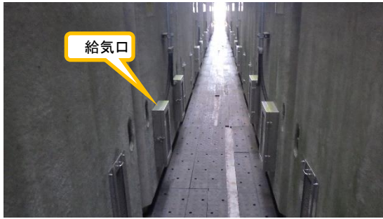
(写真 1 - 3) ボックスカルバート間の通路の状況 (壁面等に異常は確認されない。)
