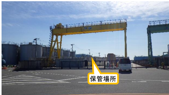
(写真 2 - 1) 第一施設北側の状況
