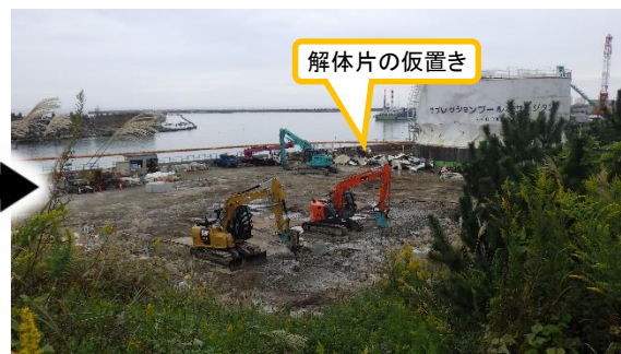
(写真1-2) 重油タンク解体後の状況 (令和2年10月22日撮影)
