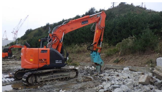
(写真3) 防油堤の解体状況
