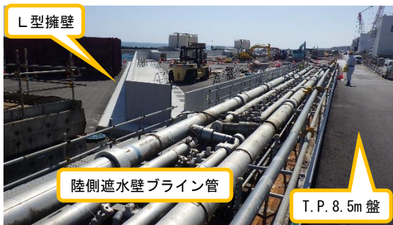
(写真 1) 1号機タービン建屋東側付近 防潮堤北端部手前 (北西側から撮影)
