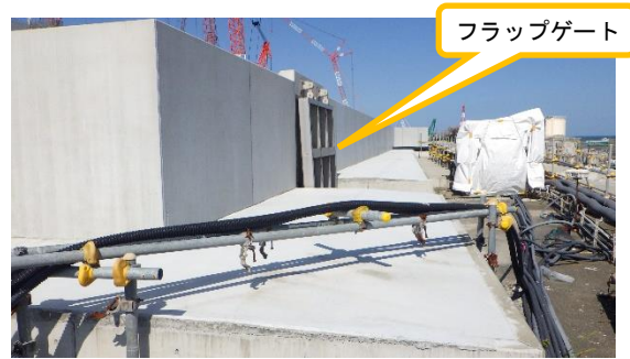
(写真 3-2) 4号機タービン建屋東側付近 (フラップゲート 海側)
