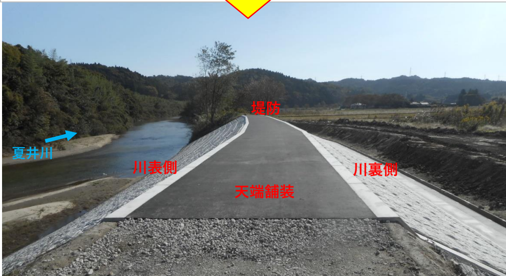
天端舗装完了 (9月末)
