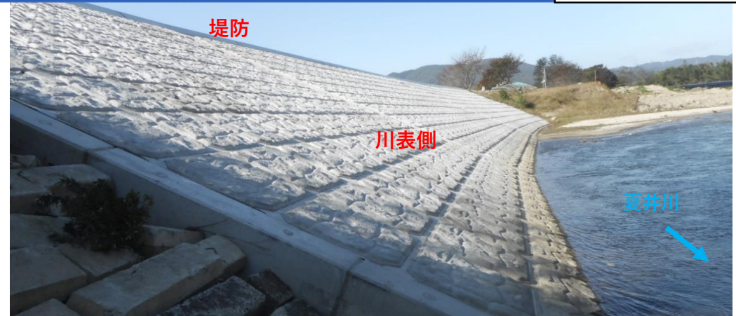
川表側 コンクリート張ブロック完了 (5月末)
