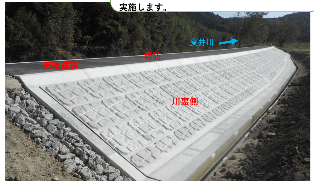
川裏側 コンクリート張ブロック完了 (8月末)
