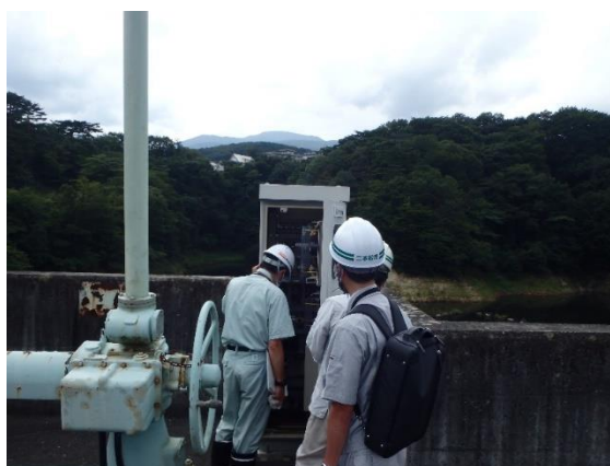
岳ダム現地確認の様子
