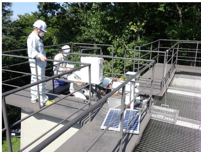
パイプライン漏水調査用機械設置の様子
