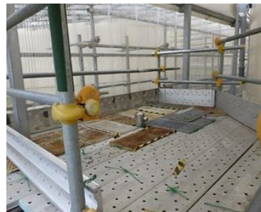
弁操作時の踊り場を設置
