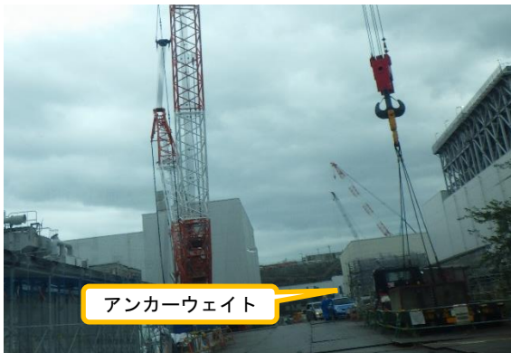
(写真3-2) アンカーウェイトが玉掛けされた大型クレーン (3号機原子炉建屋西側)
