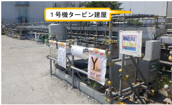
(写真1-1) 1号機タービン建屋東側の状況 (前回：令和2年8月21日)
