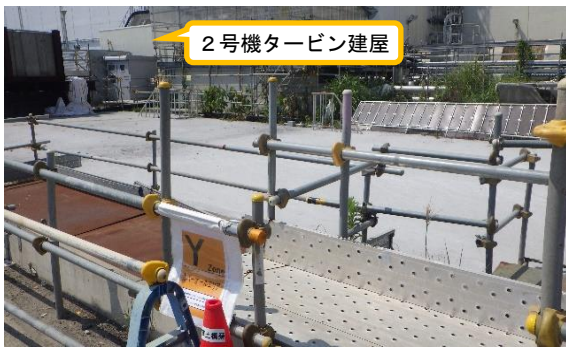
(写真2-1) 2号機タービン建屋東側の状況 (前回：令和2年8月21日)
