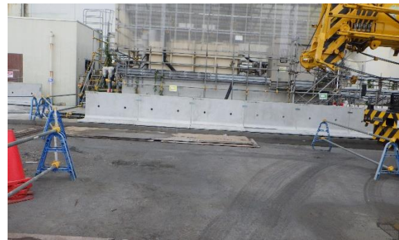
(写真2-2) フェーシングが進捗していた (今回：令和2年10月9日)
