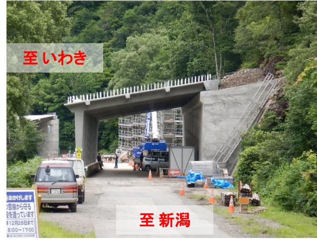
スノーシエツト工事状況
