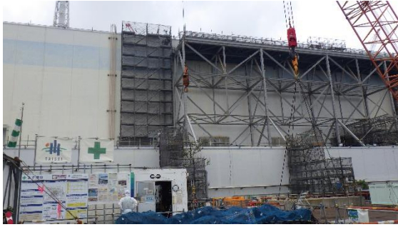
(写真1) 3号機タービン建屋外観 (南東側から撮影)
