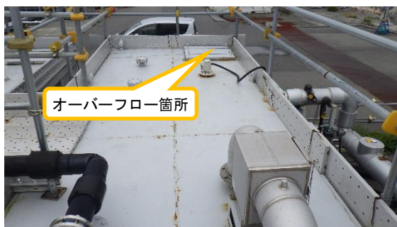
(写真4-2) タンク上部のオーバーフロー箇所
