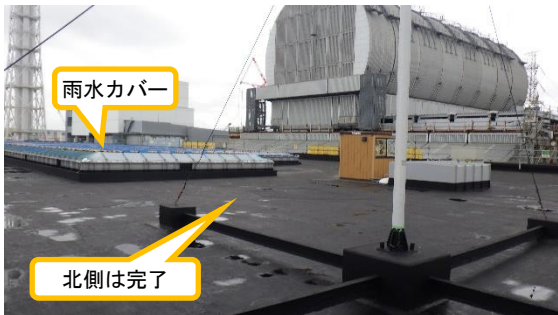
(写真2-3) 北側の状況(北東側から撮影)
