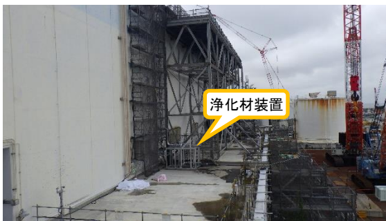
(写真3-1) 浄化材装置(設置)状況① (据え付け作業実施中)
