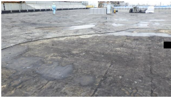
(写真2-1) 南東側(屋上入口付近) (令和2年9月1日撮影)
