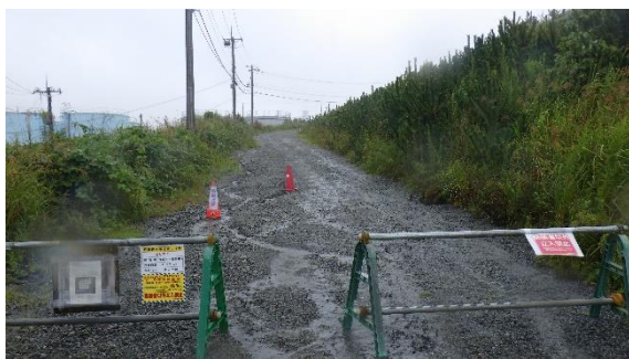
(写真 3 - 2) 進入路の状況
