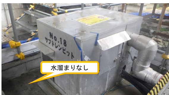
(写真 2 - 2) サブドレンピット No. 18 の状況 堰内に水溜まりの発生なし
