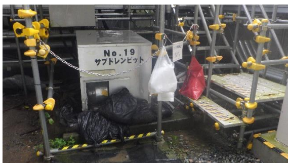
(写真 2 - 1) サブドレンピット No. 19 の状況
