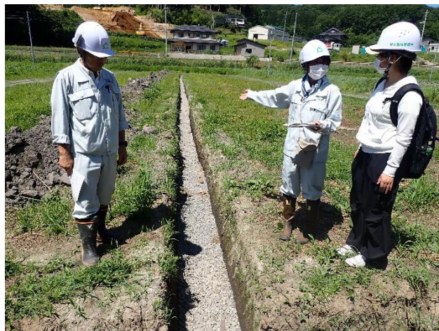
暗渠排水施工の現場見学の様子
