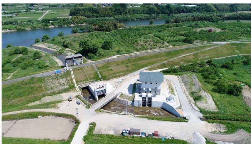
ドローンで撮った五十沢排水機場
