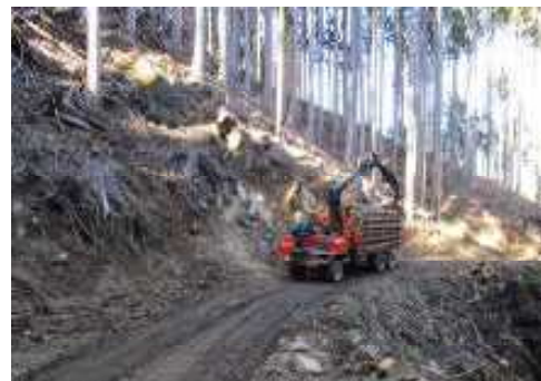
林内作業路の開設
