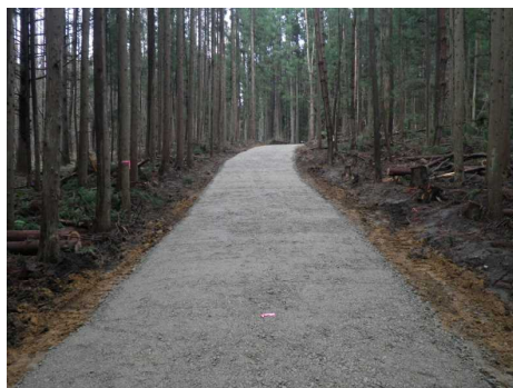
作業道の開設状況
