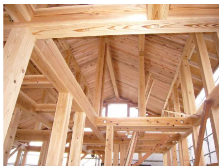
県産材を活用した住宅
