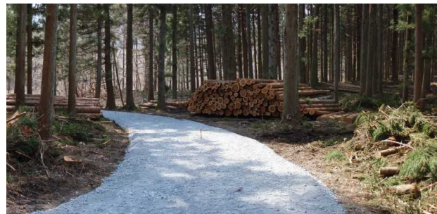
作業道の開設状況
