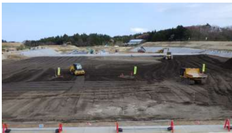
土壌貯蔵施設の稼働状況の確認
