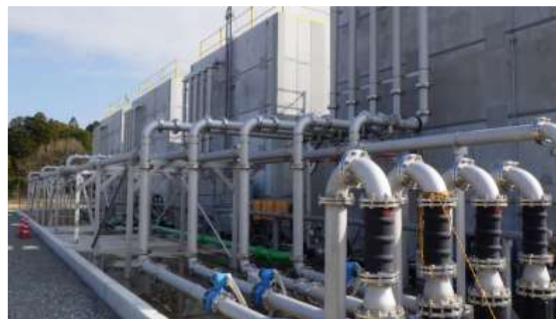
浸出水処理施設の設置状況の確認
