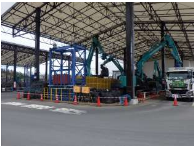
受入・分別施設の稼働状況の確認
