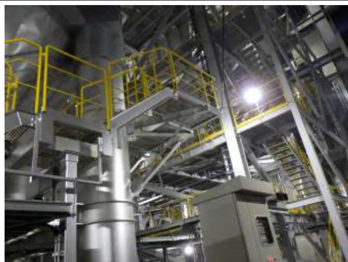
仮設焼却施設の設置状況の確認
