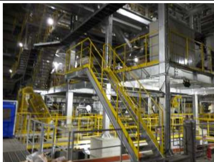
仮設灰処理施設の設置状況の確認
