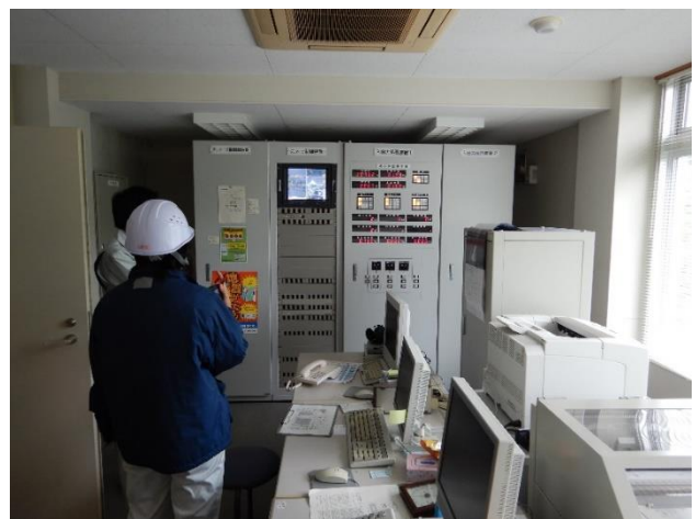
福島市大笹生ダム 観測機器・操作機器状況確認
