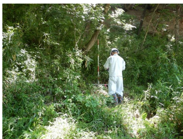
導水管の状況確認
