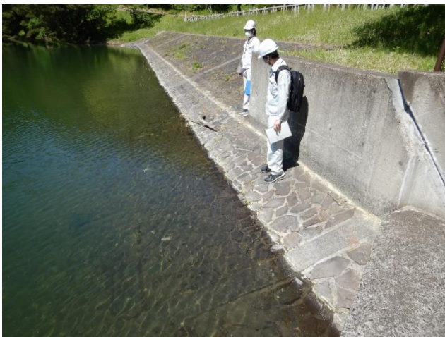
桑折町半田沼 堤体波除工状況確認
