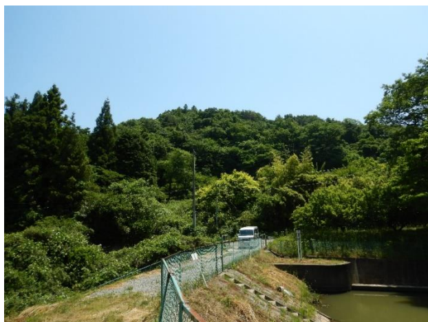
東沢地区の地すべり対策実施済み箇所
