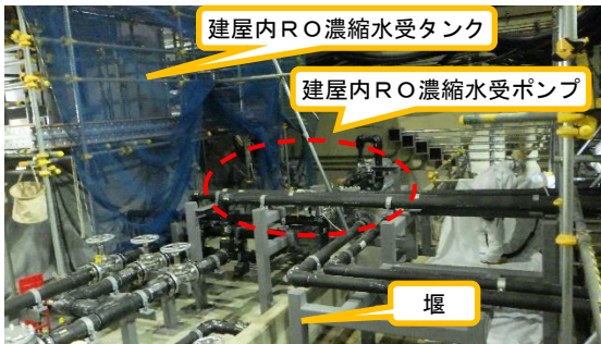
(写真1-2) 北西側から撮影
