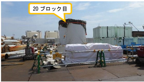
(写真 3) 20ブロック目仮置き状況
