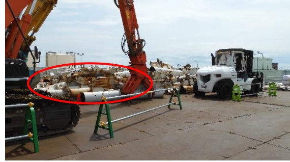
(写真 2-2) 同左 本日撮影 主に赤丸部分の鉄塔が増えていた
