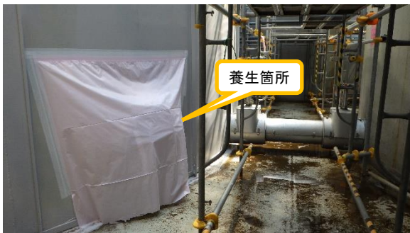
(写真2) サイドマンホール養生の例 (B3タンク) ※プラスチック製のシートの中に袋養生されたサイドマンホールがある。
