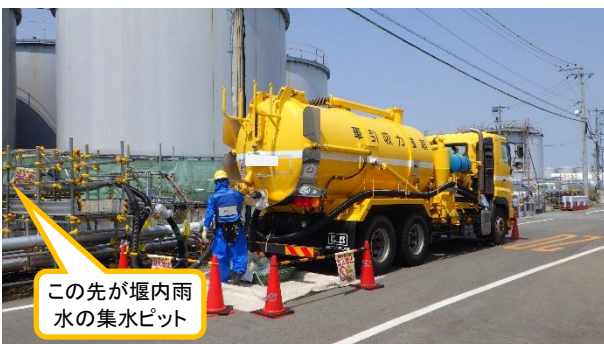
(写真4) 吸引車による堰内雨水の回収状況
