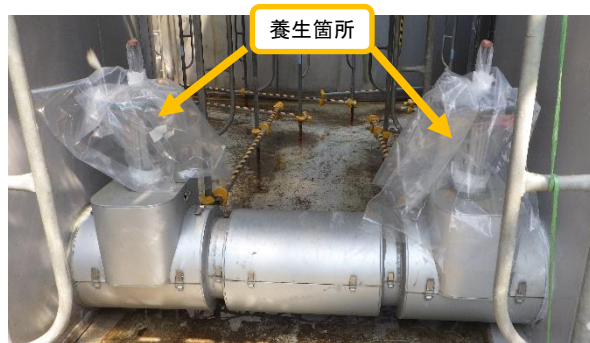
(写真3) 連結弁養生の例 (B6-B7間の連結弁)
