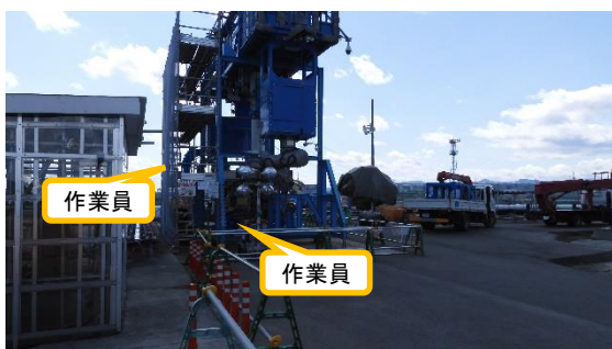
(写真5) 排気筒解体装置メンテナンスの状況
