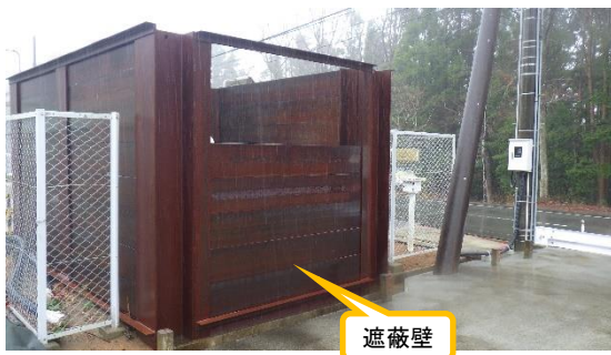
(写真3-2) 線量率測定器周囲の遮蔽壁設置状況 (北側から撮影)
