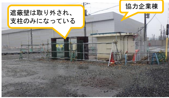
(写真2) モニタリングポストNo. 6 (南西側から撮影)
