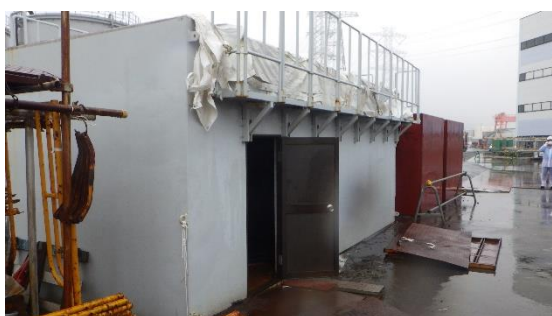
(写真4) 資材倉庫の外観
