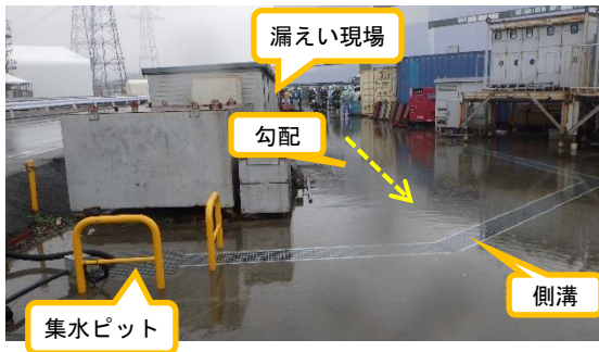
(写真7) 集水ピット周辺の状況（資材倉庫の 下流側） 当該箇所では油膜は見られなかった
