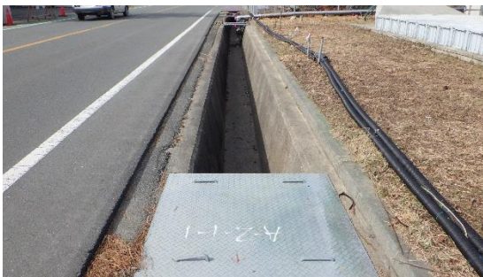
(写真2-1) 免震重要棟近傍の側溝の状況 (東側から撮影)
