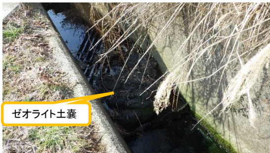
(写真1) ゼオライト土嚢設置状況
