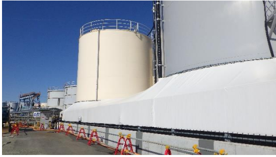
(写真1-1) G1南タンクエリア南側外観
