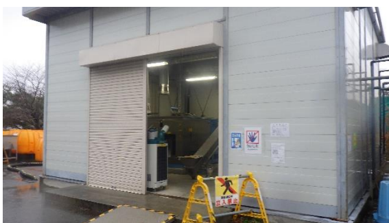
(写真 1 - 3) 既設処理施設が設置されている建屋
