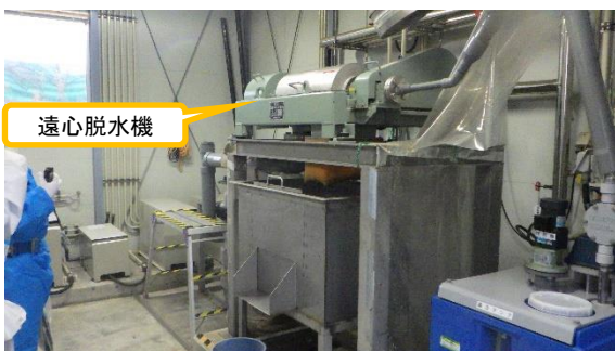
(写真 1 - 4) 既設処理施設外観
