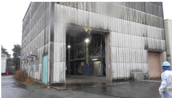
(写真 1 - 1) 新設処理施設が設置されている建屋
