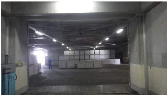
（写真1－3）第3棟内部の状況
