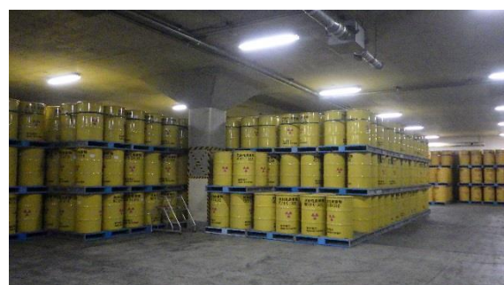
（写真1－4）第4棟内部の状況
