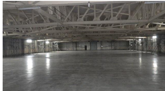
（写真1－2）第2棟内部の状況
