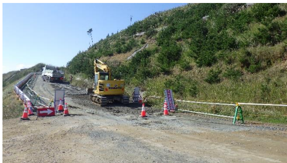
(写真2) 進入路の補修状況 ( (北側) 土木材料プラント側から撮影)
